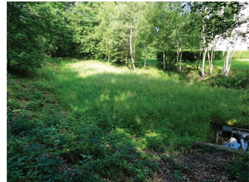
Bassin récupérateur d'eau pluviale entre l'IUT et l'UFR Pharmacie
