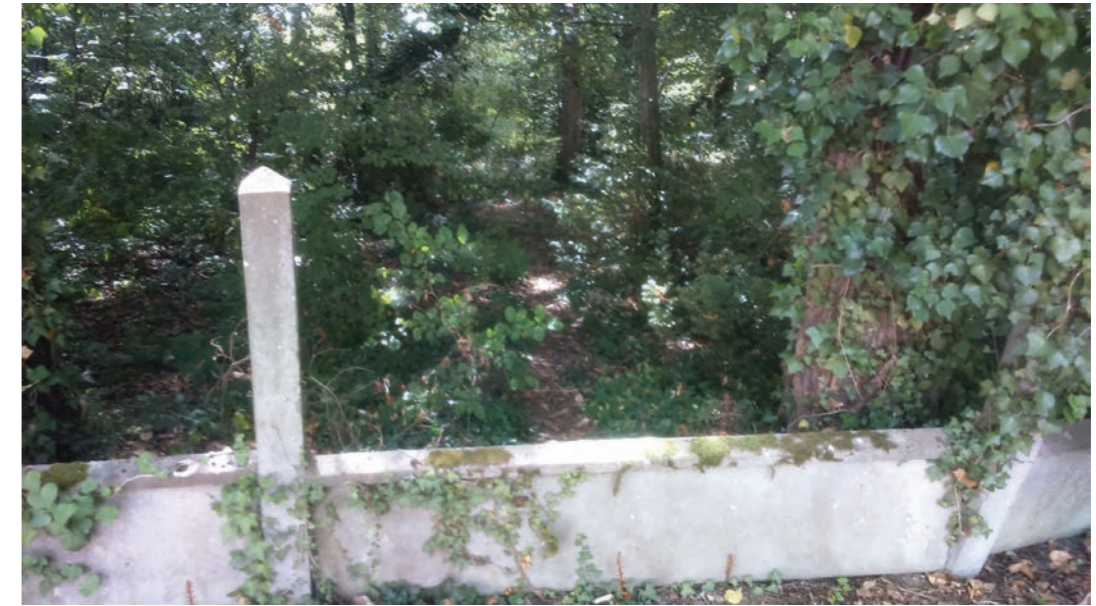
Entrée informelle à supprimer
