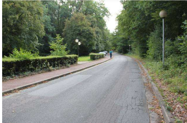
Pelouses de parcs et haie ornementales (ici, à gauche de la voie)
