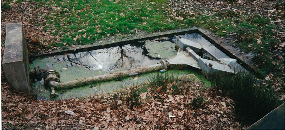
FIGURE 7 – Photo du collecteur d’eaux pluviales. [Delamour et al., 2000]
