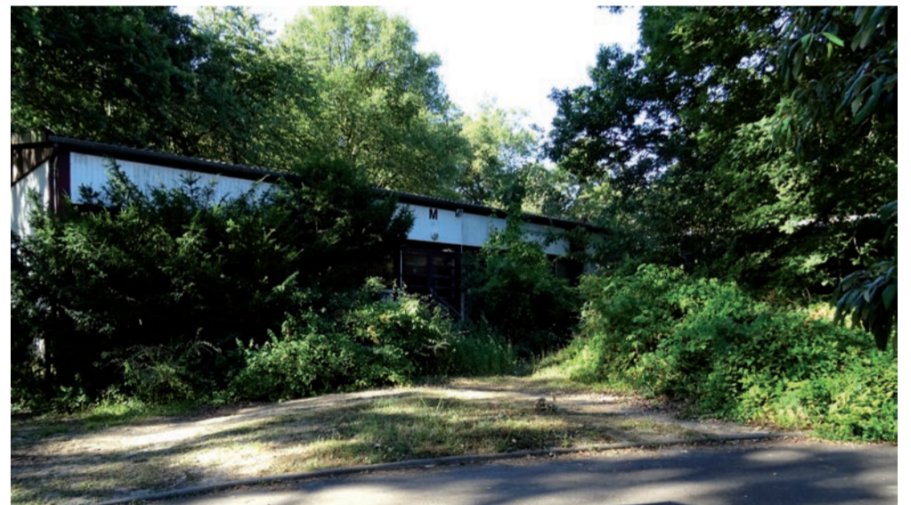
Préfabriqué à l'abandon
