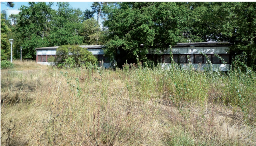
Zone en friche à l'emplacement des préfabriqués démolis
